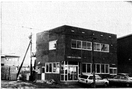
(株) 種田コンクリート工業所
