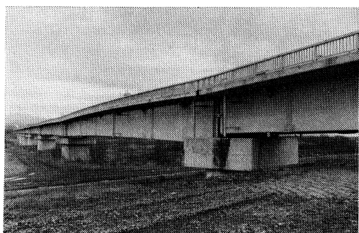
下水道排水橋
