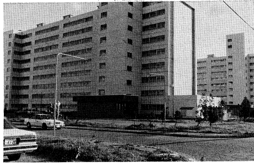
啓南団地高層住宅
