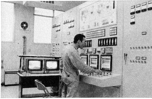
清掃センター（操作場）
