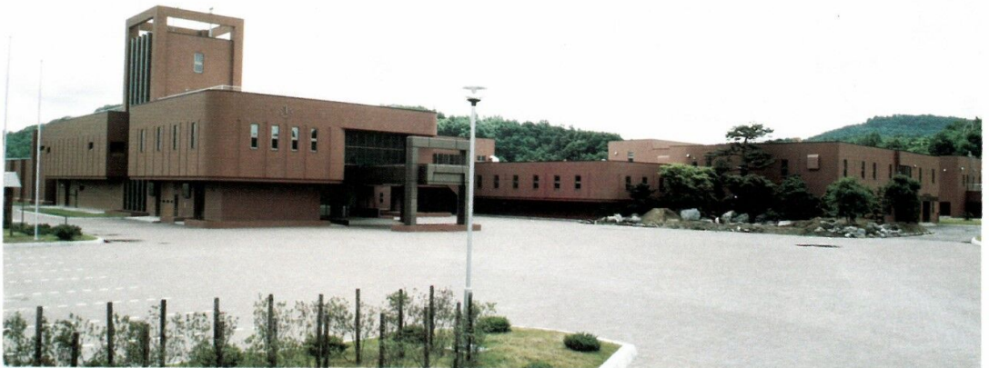
空知川(滝里ダム)から取水する中空知広域水道企業団の 浄水場 (平成2年4月1日通水)
