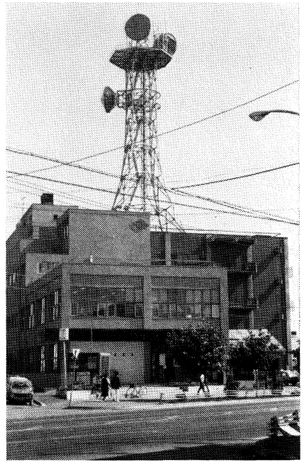
滝川電報電話局・滝川統制電話中継所
