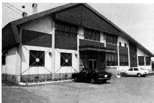
札幌土木現業所滝川出張所庁舎
