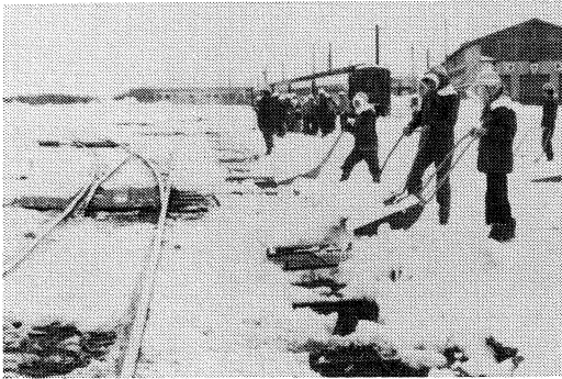
滝川駅構内流雪溝排雪作業
