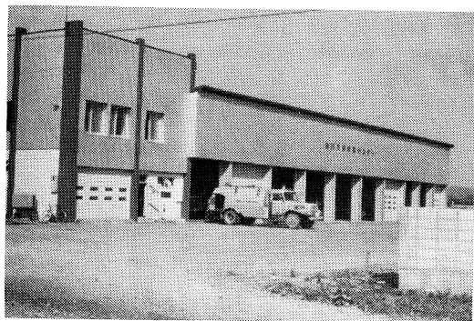
除排雪センター
