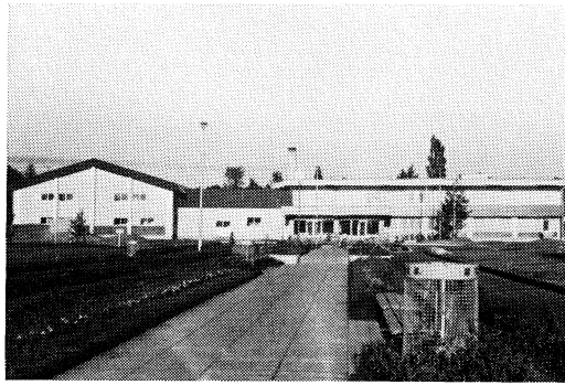
江部乙農村環境改善センター
