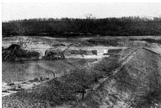
改修前の1号貯水池
