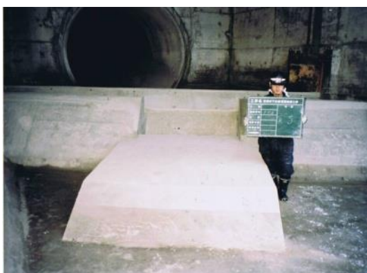
図 雨水吐きの堰の嵩上げ
