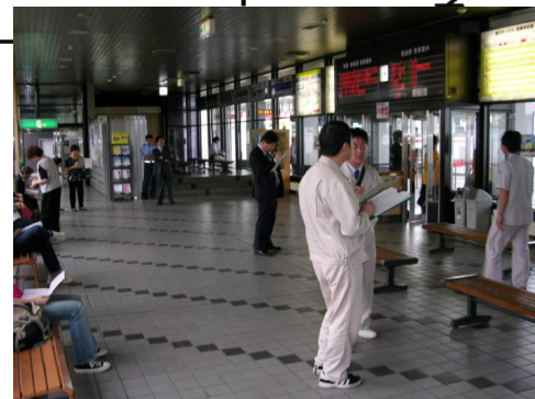
■ バスターミナル内に点字ブロックが敷設されていない。
