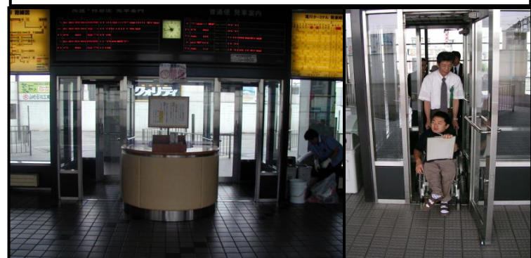
■ 通路幅が狭く車椅子の大きさによっては、通過困難な改札口。 ■ 手動式のため開閉に困難。
