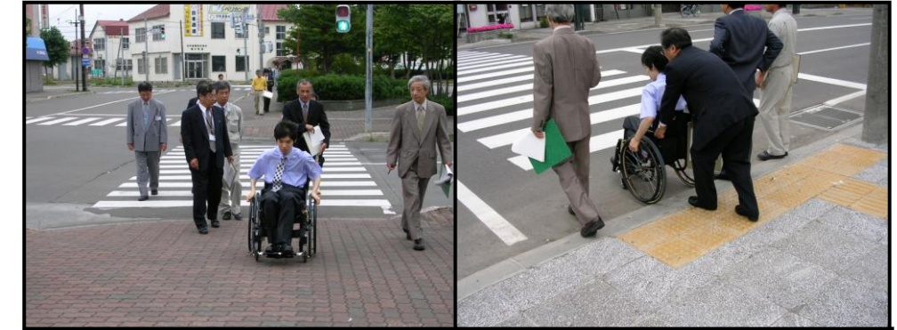
■歩道と車道の段差が高く、ところどころ一人では歩行が困難な箇所がある。 ■勾配がきつく歩行に困難である。 ■交差点を示す警告ブロックはあるが、老朽化や識別不可能な箇所がある。 ■横断歩道及び周辺に段差付のマンホールがあり歩行の障害となっている。
