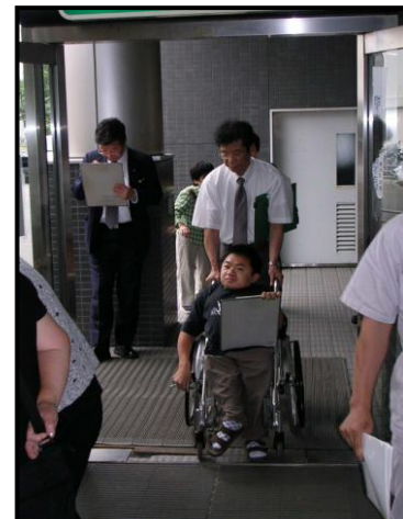
■ 出入口の段差が車椅子利用者の障害となっている。 ■ 出入口のドアが重く開閉は困難である。
