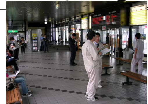
■ バスターミナル内に点字ブロックが敷設されていない。
