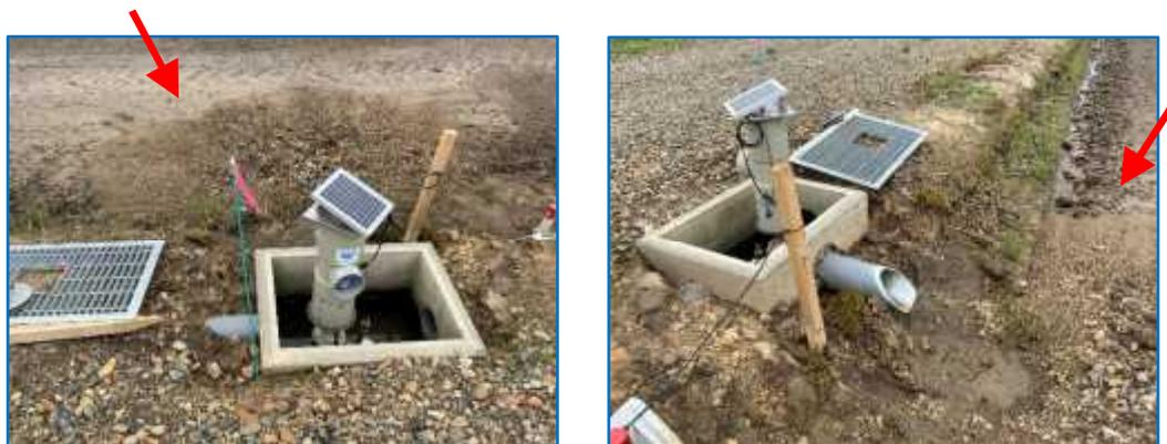
図 35. 給水栓柵周辺の土砂がほ場に流出した状況（矢印部分）
