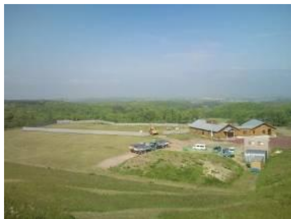
完成に向け建設が進むそらぶちキッズキャンプ
