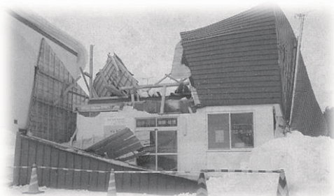
3月4日屋根に積もった雪の重みで倒壊した学習塾(滝川市西町)@プレス空知
