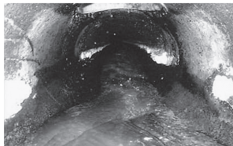
洗浄後の下水道管の写真
