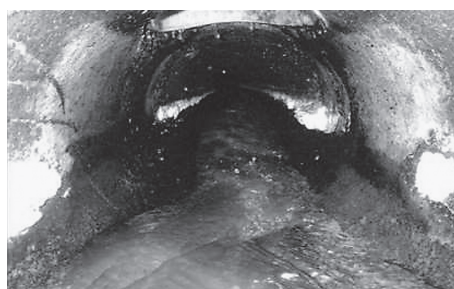
洗浄後の下水道管の写真
