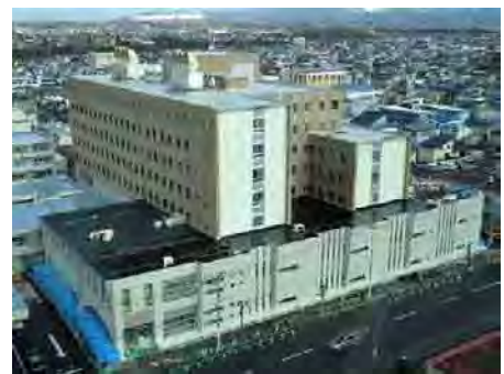
図 4.19 建設中の市立病院 (H22 現在)
