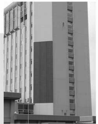
滝川市役所の太陽光発電パネル
