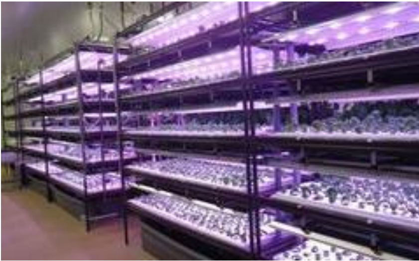
約100坪の空間に5段式ユニットを48台導入
