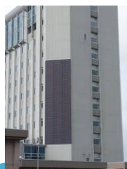
滝川市役所の庁舎壁面に設置された太陽光発電パネル(写真中央部)
