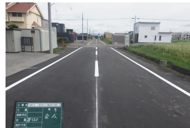
道路工事完了後の状況
