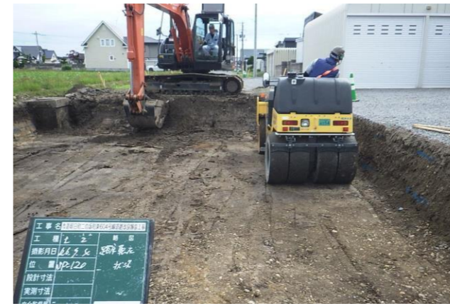
道路工事の施工状況
