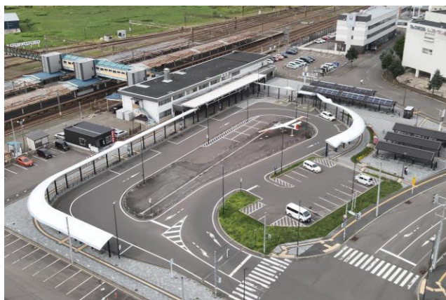
都市計画事業によって整備した駅前広場
