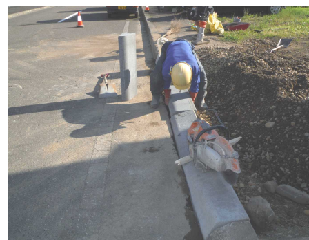
縁石設置状況
