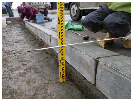
路床高さ測定
