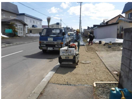
路盤転圧状況
