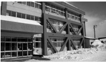
▲学校耐震化工事
