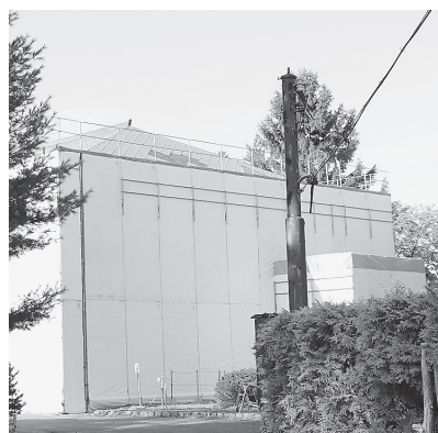
▲解体工事中の市民会館
