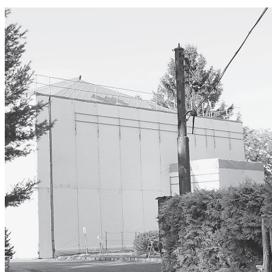
▲解体工事中の市民会館
